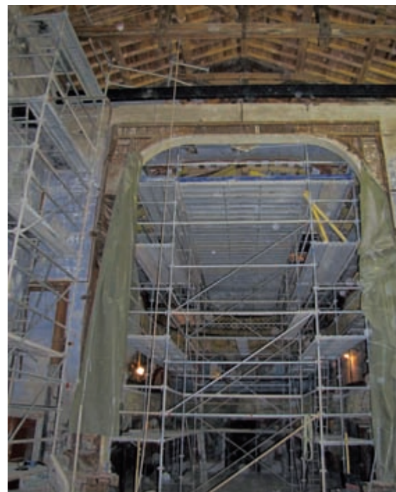
Une forêt d'échafaudages a envahi les lieux.
